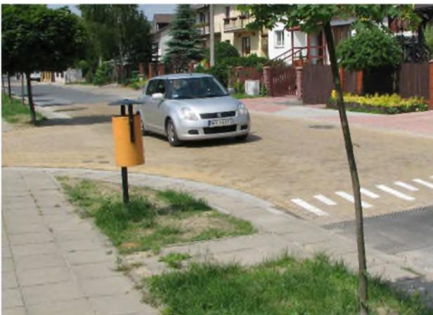
Abbildung 7-5: Aufpflasterung am Knotenpunkt
